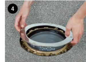
4 トリムを所定の位置に設置します。(ビス固定式のトリムの場合はトリム設置前にチルト位置を設定してください。)
