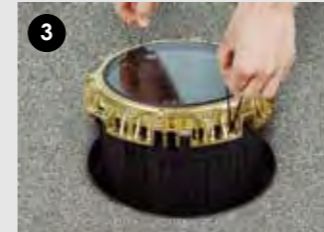
3 灯具に付属するストラップを使って灯具を埋め込みボックスに挿入します。（この時に照射方向に灯具の向きを合わせてください。）
