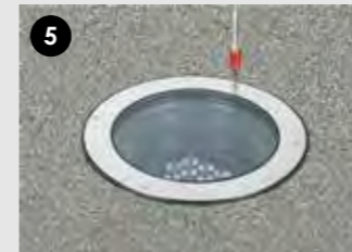
5 ビス固定式のトリムの場合はトリムを4本のビスで固定してください。
