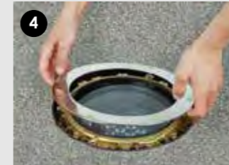
4 トリムを所定の位置に設置します。（ビス固定式のトリムの場合はトリム設置前にチルト位置を設定してください。）
