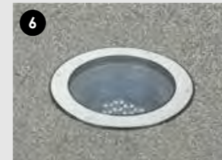
6 施工完了です。ワンタッチ固定のトリムの場合設置後のチルト操作が可能です。
