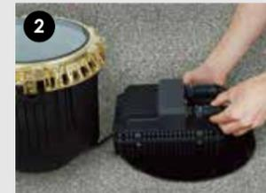
2 電源ボックスを埋め込みボックスに設置します。（灯具と電源ボックスは接続された状態が出荷されます。）
