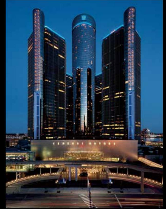
アメリカ最大の自動車メーカーの再興を象徴し、デトロイトのシンボルの存在感をより一層強めたプロジェクト。Lumenbeamが20階まである吹き抜けのガラス天井を照らし、外へと溢れ出る光を作りました。高出力のLBXを使用することで、4つのタワーは各4台の器具のみで天井の陰影を鮮明に映し出すのに十分な輝きを実現。器具はデトロイト川の強風にも耐え得るよう天井にポールで固定。高耐久のLumenbeamは、デュアルチャンバー設計により熱を放散し、120,000時間の長寿命を実現してメンテナンス問題も解消しました。
